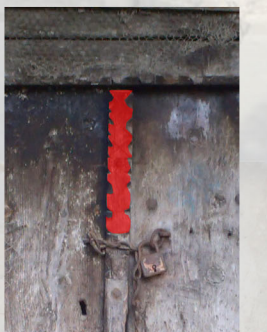
Γεωμετρικές λεπτομέρειες κατεργασίας του ξύλου σε πόρτες
